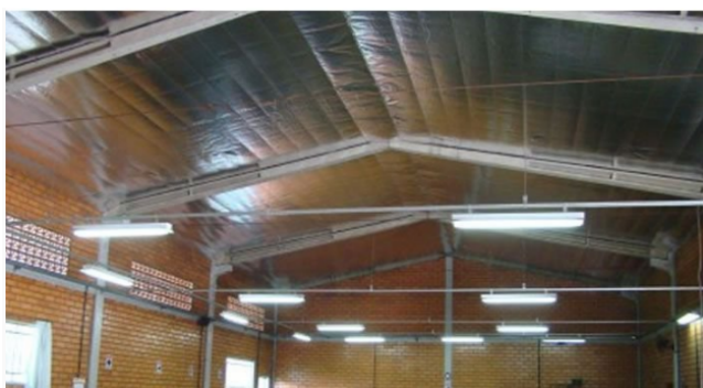
Detalhe Instalação Manta Subcobertura
